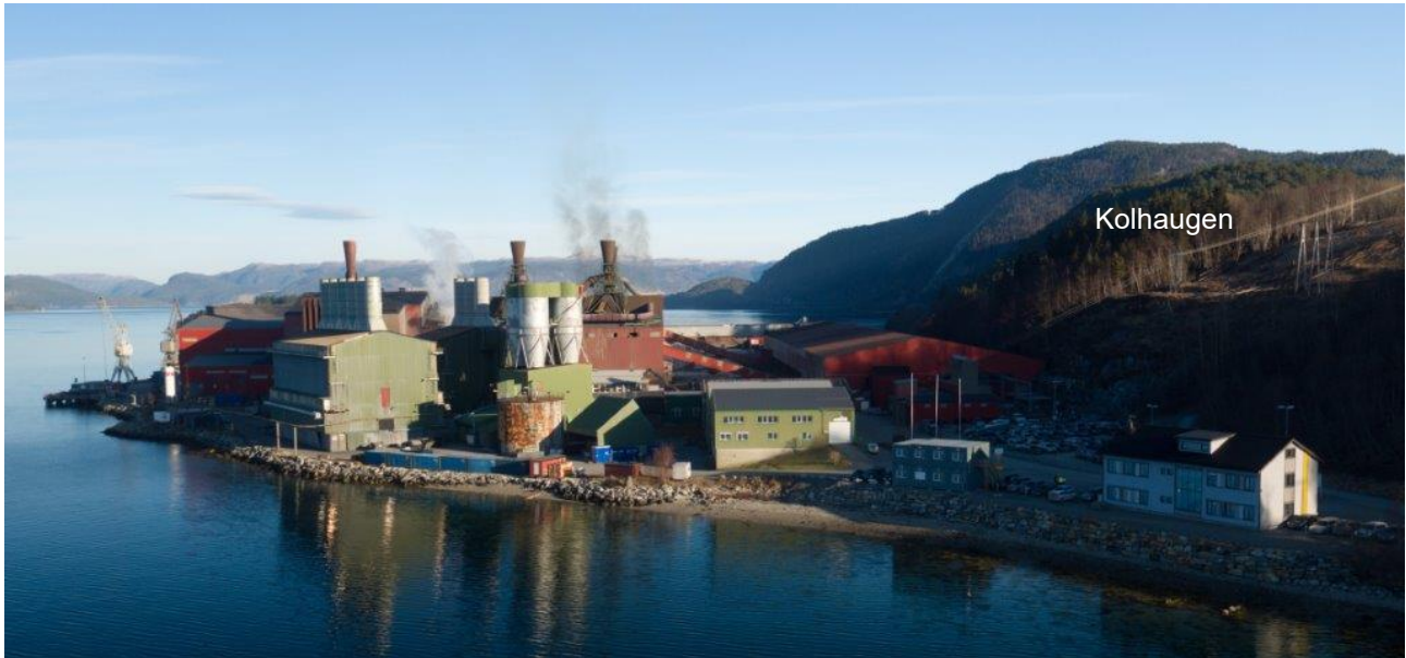
Figur 3-7 I Kolhaugen er det i dag inngrep bl.a. i form av 3 kraftlinjer. Veggen danner likevel en markert og fin avslutning av fabrikkområdet mot sørøst. Langs sjøen er det kunstige fyllinger av ulik visuell kvalitet. Foto: Wacker Holla
