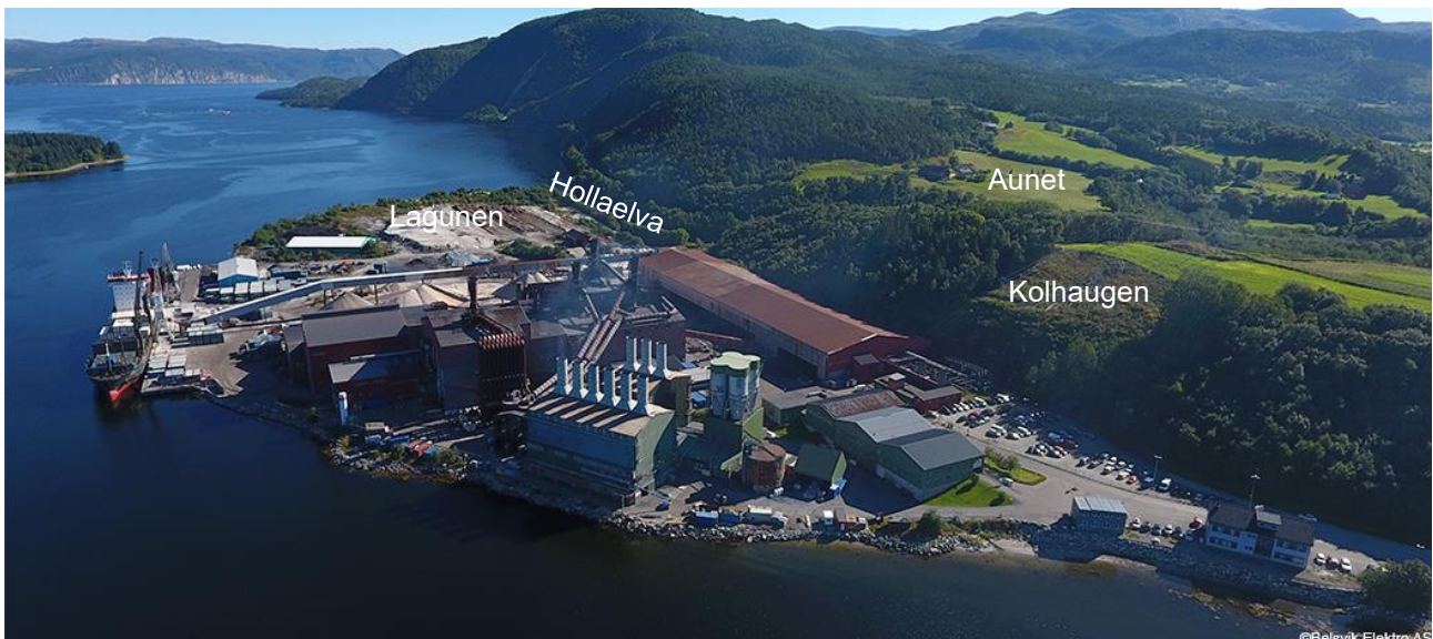
Figur 3-6 I søndre deler av fabrikkområdet danner Kolhaugen en vegg i landskapet ved fabrikken. Videre nordover er den skogkledte lia øst for Hollaelva en vegg i landskapsrommet. Foto: Wacker Holla
