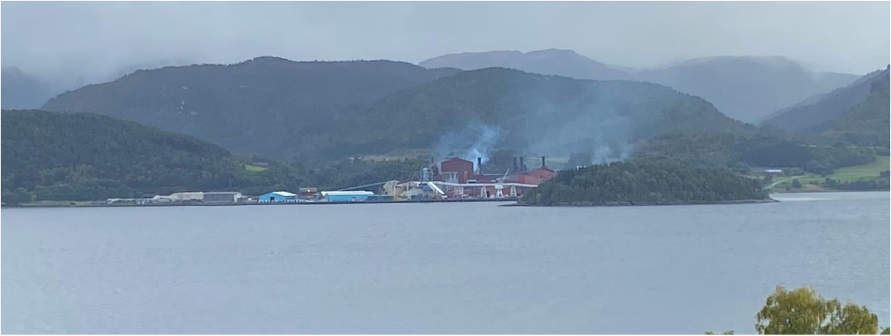
Figur 3-17 Fabrikkområdet er eksponert mot midtre og indre deler av Hemnfjorden. Bilde sett fra Lernesstranda på vestsida av Hemnfjorden. Skogholmen ligger foran fabrikken til høyre i bildet. Det er innsyn til fabrikkområdet fra store deler av bebyggelsen på vestsida av fjorden fram til Lernesodden og delvis fram til Storodden (se også figur 3-3). Fra området der bildet over er tatt er det ca 2 km over til fjorden til fabrikkområdet på Holla. Foto: Norconsult
