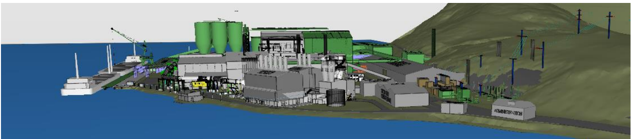
Figur 5-20 Fabrikkanlegget sett fra sørvest. De nye smelteovnene (grønne bygninger ca midt i bildet) kan ha tilnærmet samme høyde som dagens smelteovner (kote +55). De nye siløene kan ha maks høyde kote +60.
